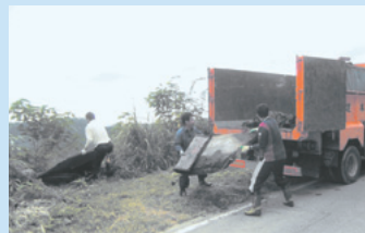
不法投棄廃棄物撤去作業
