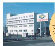
南大阪支店・流通センター
