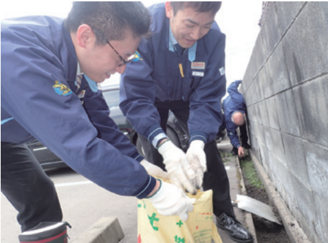
周辺道路側溝清掃
