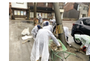
1月13日 トナミ運輸労働組合執行委員が、高岡市伏木地区の側溝にたまった土砂の排出作業のボランティアに参加した様子
